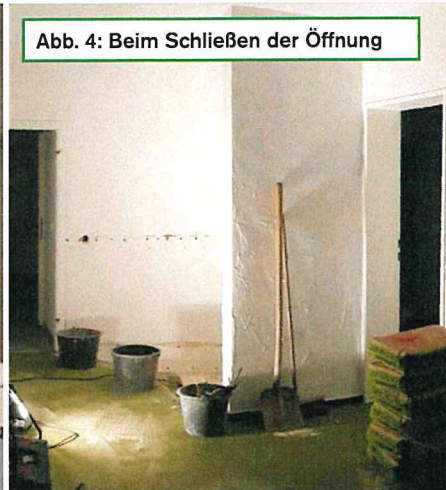
Abb. 3, 4 und 5: In diesem Beispiel wurde eine alte Verkofferung geöffnet. Darunter fand sich eine Öffnung in der Decke, die aus Brand-schutzgründen geschlossen wurde.
